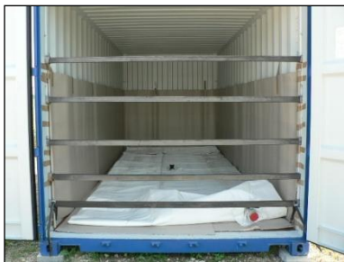
Inštalácia oceľových tyčí
